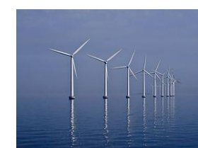
Pali per impianti eolici
